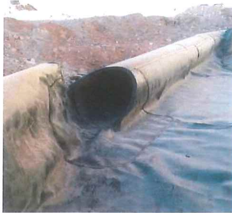
Figura 3-11: Impermeabilización de descarga al Canal
