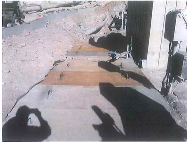
Figura 3-14: Fabricación e instalación de planchas sobre desarenador IPA2
