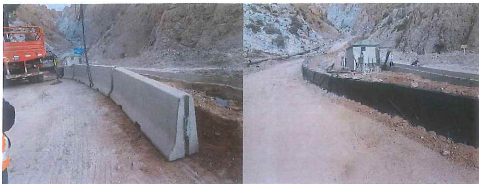
Figura 3-16: Instalación de new jersey (10-04-2018)
