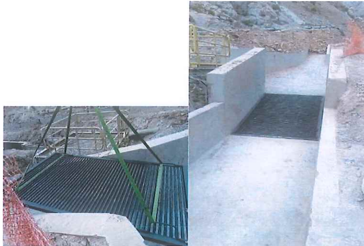
Figura 3-2: Instalación Parrilla en sumidero (10-04-2018)
