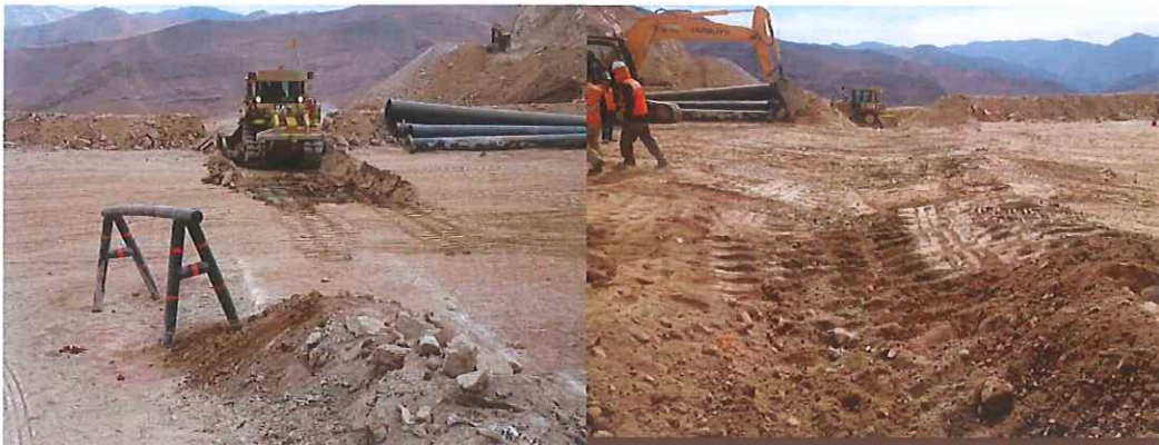
Figura 3-3: Construcción de badén continuación zanja (10-04-2018)
