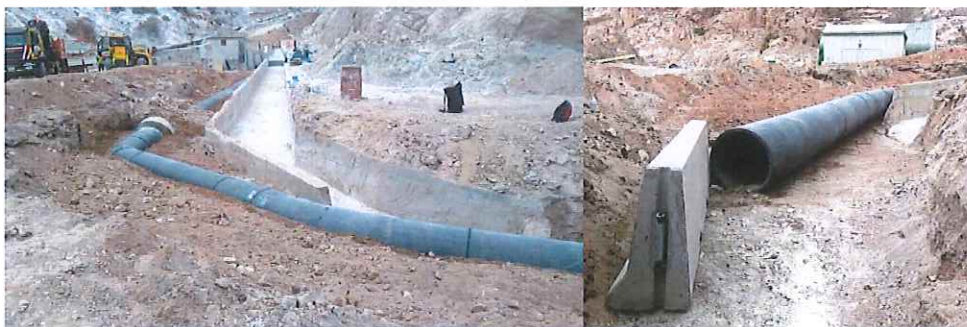
Figura 3-10: Relleno zanja de tubería 800 mm (10-04-2018)
