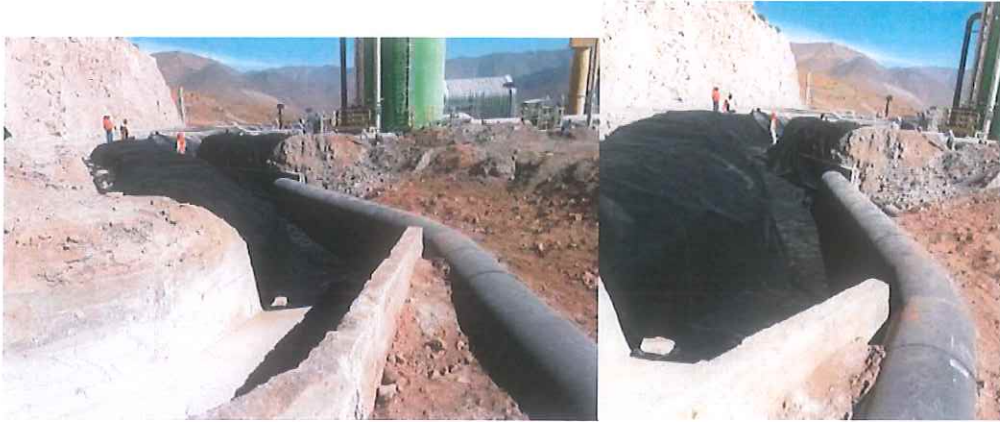
Figura 3-4: Avance impermeabilización zanja (12-04-2018)
